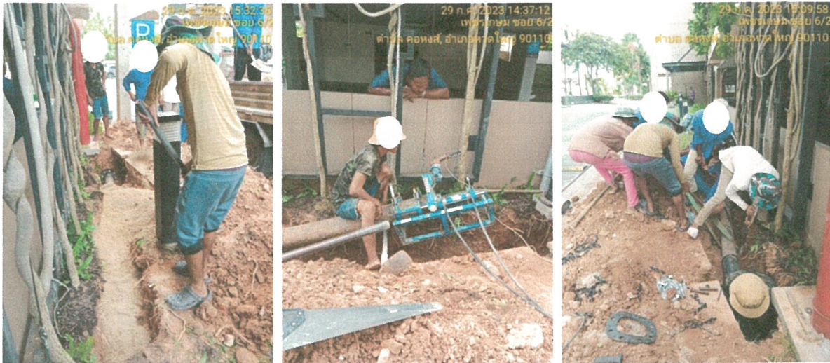
รูปภาพที่ 2.2 การตรวจสอบรอยรั่วของท่อประปา
