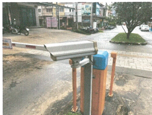
รูปภาพที่ 2.16 ระบบควบคุมการเข้า-ออก (Access Control) และระบบกล้องโทรทัศน์วงจรปิด (CCTV)
