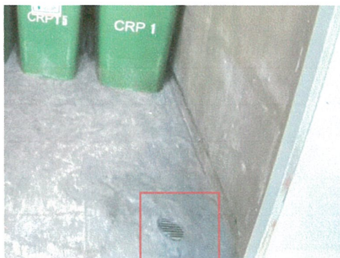
รูปภาพที่ 2.41 รางระบายน้ำห้องพักรมูลฝอย
