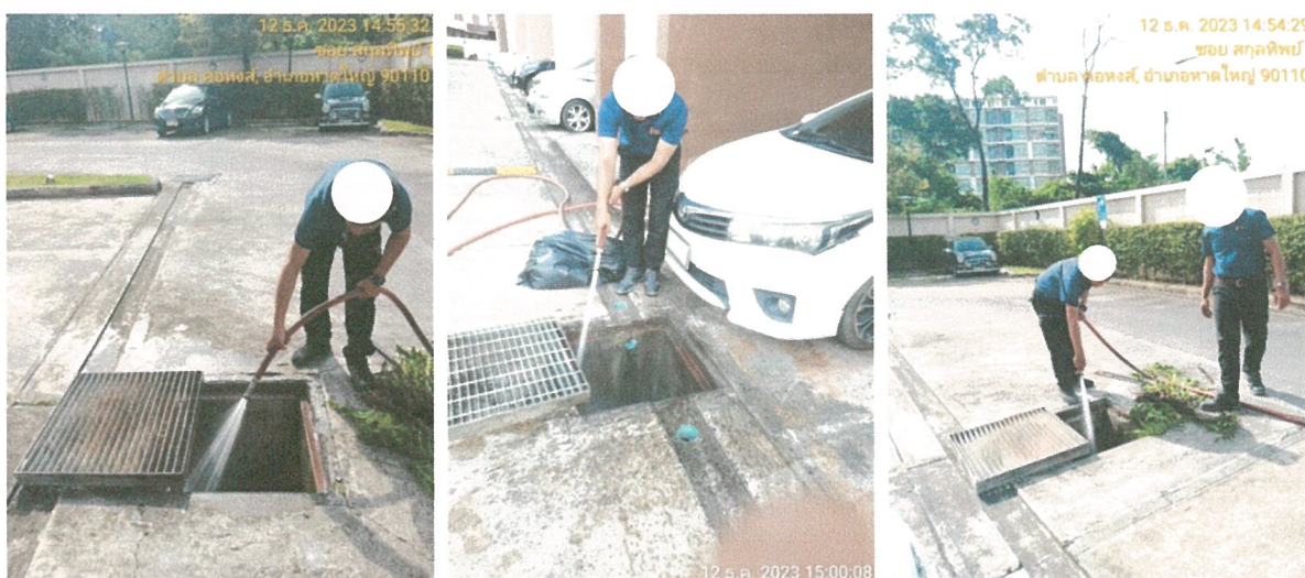
รูปภาพที่ 2.66 การขุดลอกท่อและวางระบายน้ำ
