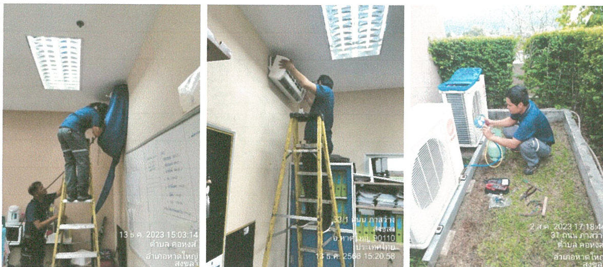
รูปภาพที่ 2.31 การทำความสะอาดระบบปรับอากาศ
